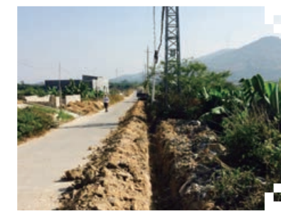
在陆丰金厢镇修建中的饮水工程
